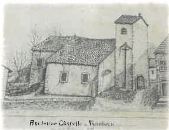
Chapelle démolie le 13 janvier 1890
